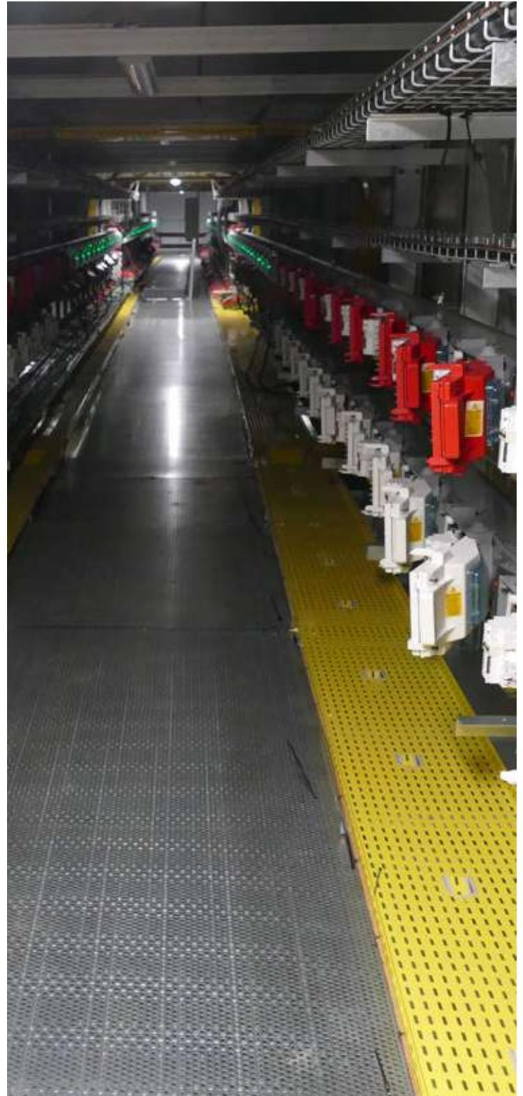
Le plafond d'une allée, distribution du refroidissement, de l'électricité et du réseau
